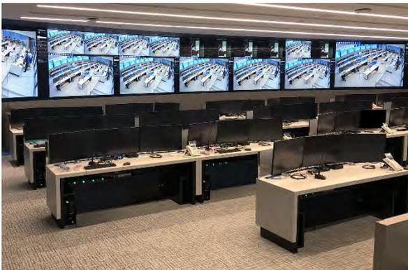
このモニターシステムは48面のビデオウォールになっています。今回、モニターにベゼルが極力ないもの（世界最薄レベル0.44mm ※1）を採用しました。さらに、大画面が湾曲した作りになっています。隙間をmm単位で調整し、48面がバランスよく、歪みなく設置されています。時間のかかる作業でしたが、綺麗に取付ける事が出来ました。
